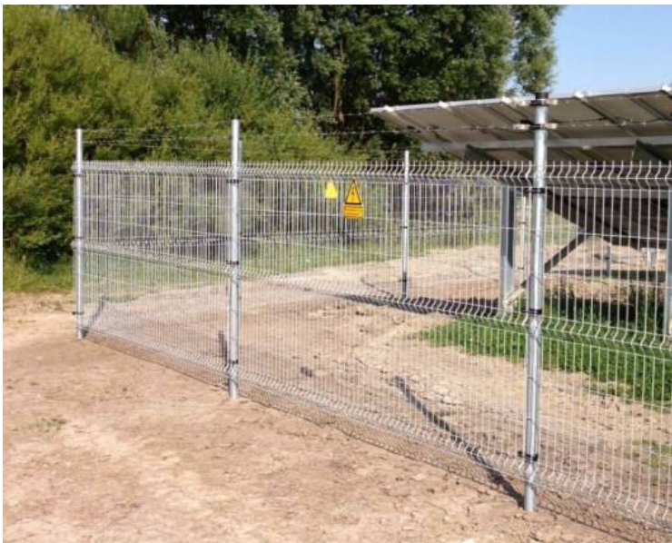
Beispiel einer Zaunanlage 2,5 m Höhe inklusive Übersteigschutz
